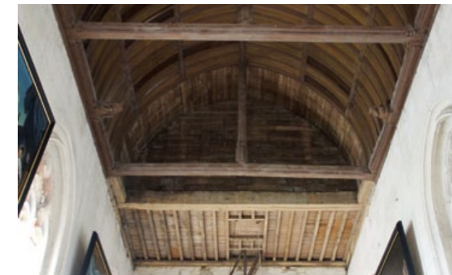
Voûte en berceau de la nef
